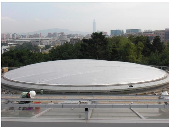
圖七 ETFE 薄膜屋頂完成
