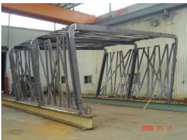
圖九 花之隧道鋼結構假安裝
