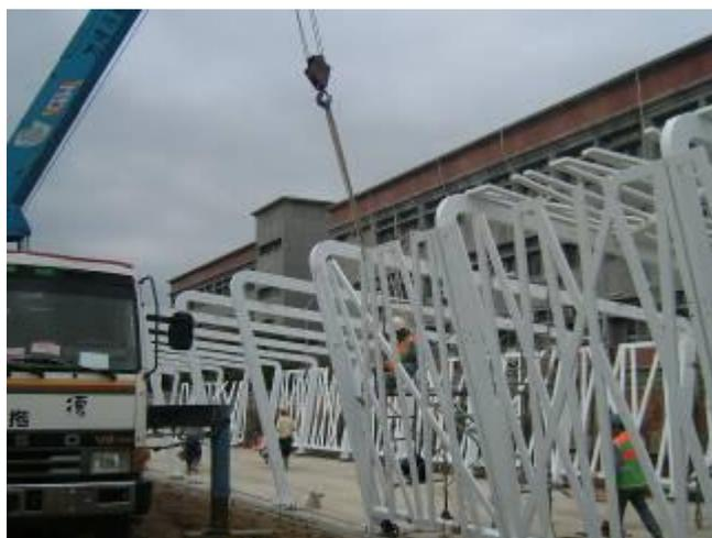
圖十二 花之隧道鋼結構吊裝
