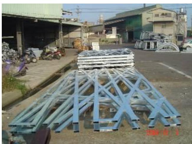
圖十 花之隧道鋼結構熱浸鍍鋅完成
