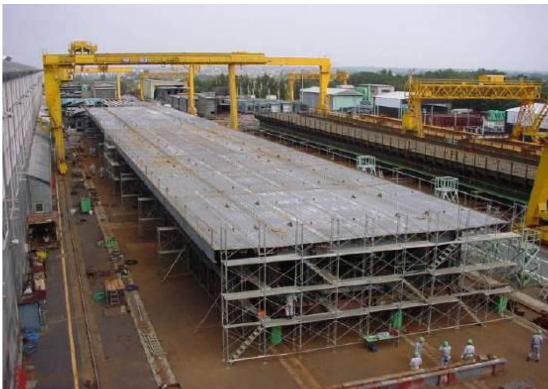
圖片 3-10(標準鋼橋預裝場)
