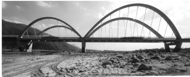
圖十四 新威鋼橋
