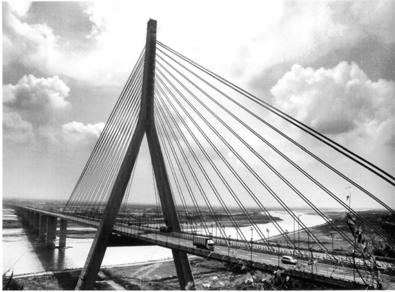
圖十五 高屏斜張大橋
