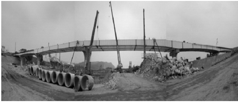
圖十六 重建之後豐鋼橋吊裝（榮重鋼構）
