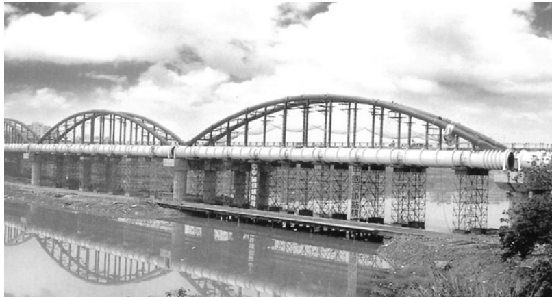
圖十八 鋼拱水管橋
