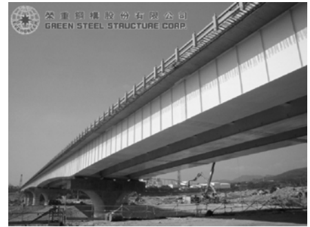
圖十七 完工後之後豐橋（榮重鋼構）
