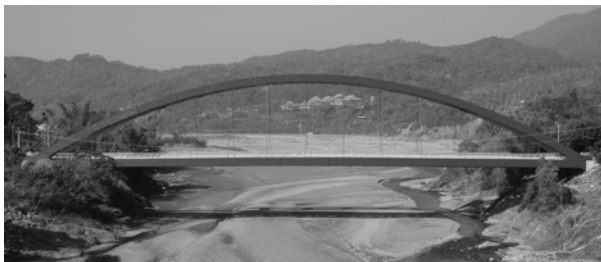
圖十三 東溪鋼橋
