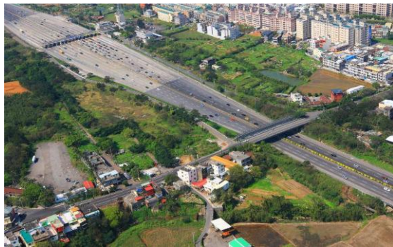
圖七(a)、校前路跨越橋改建前
