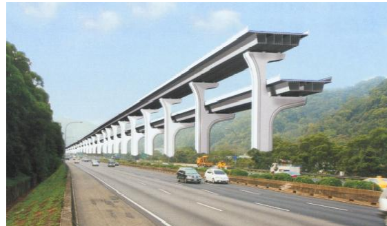
圖三、RC 單柱上構鋼橋雙層
