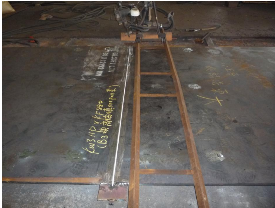
載具試體銲接施工作業前外觀情形 圖 1
