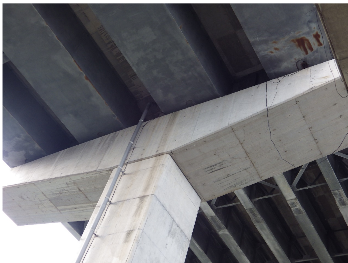
圖十三 台北橋三重端上方熔射箱梁(一標)生銹外觀(一)
