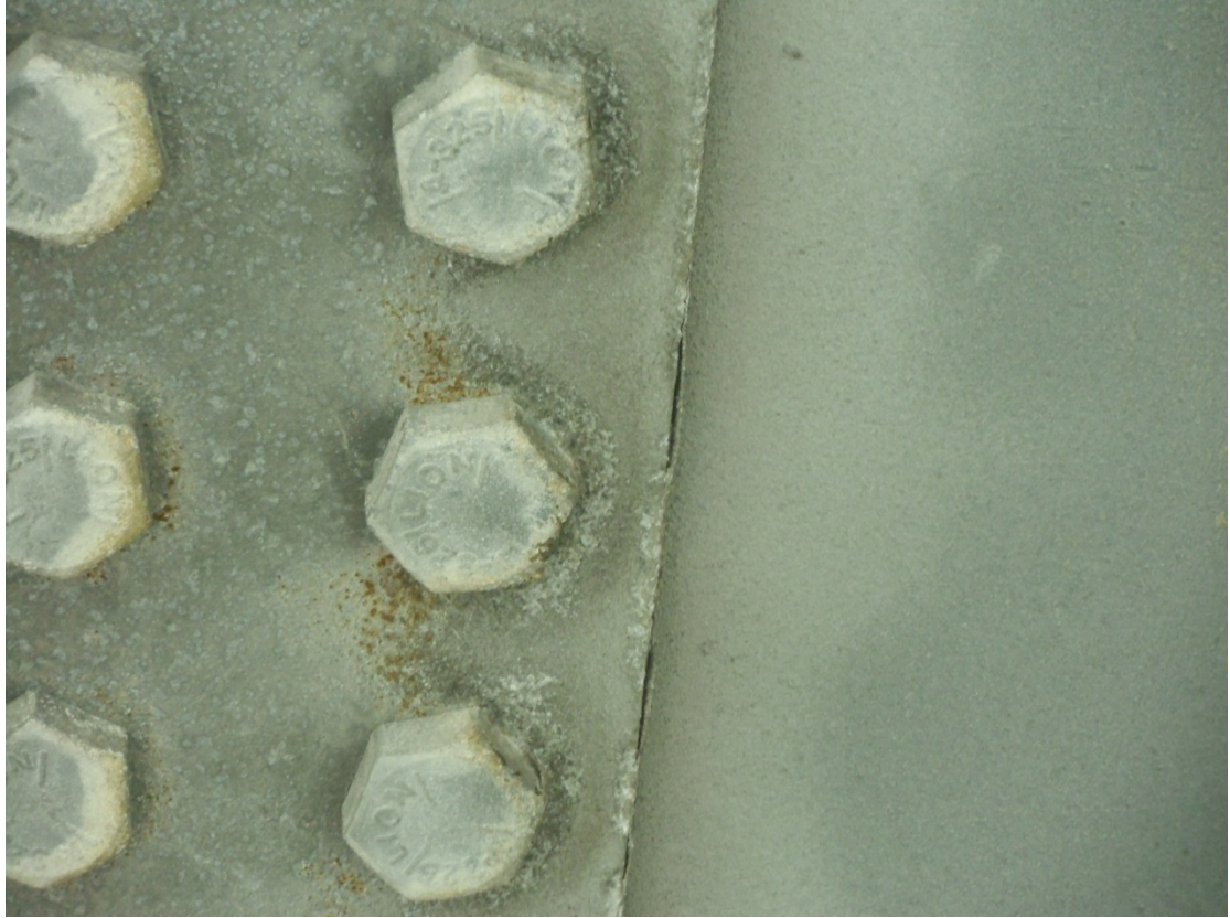
圖十六 連接板板厚端熔射層剝離
