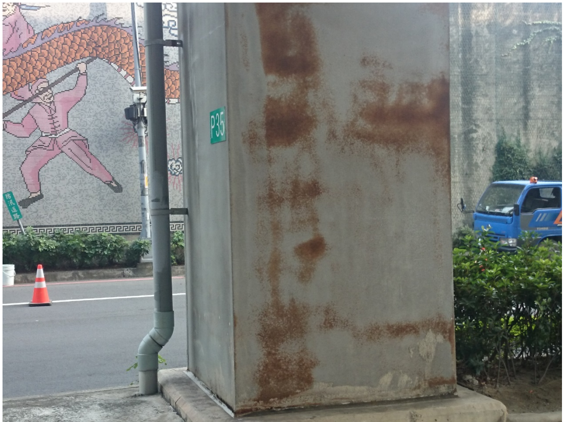
圖十七 P35 橋墩生銹外觀(熔射)
