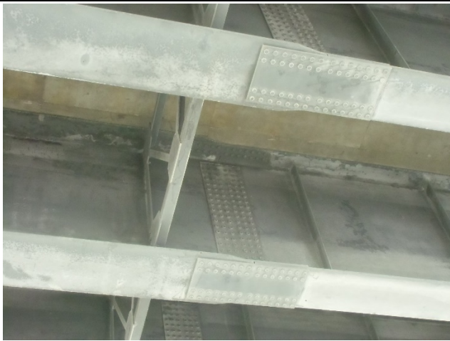
圖十一 台北橋北側上方熱浸鍍鋅板梁(一標)外觀
