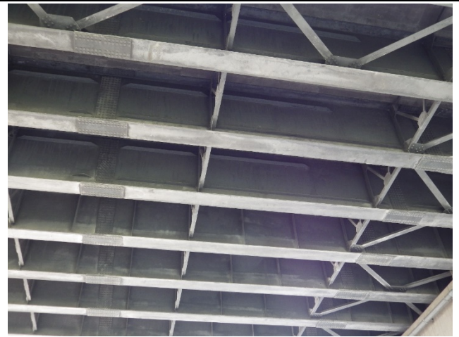
圖十一 台北橋北側上方熱浸鍍鋅板梁(一標)外觀
