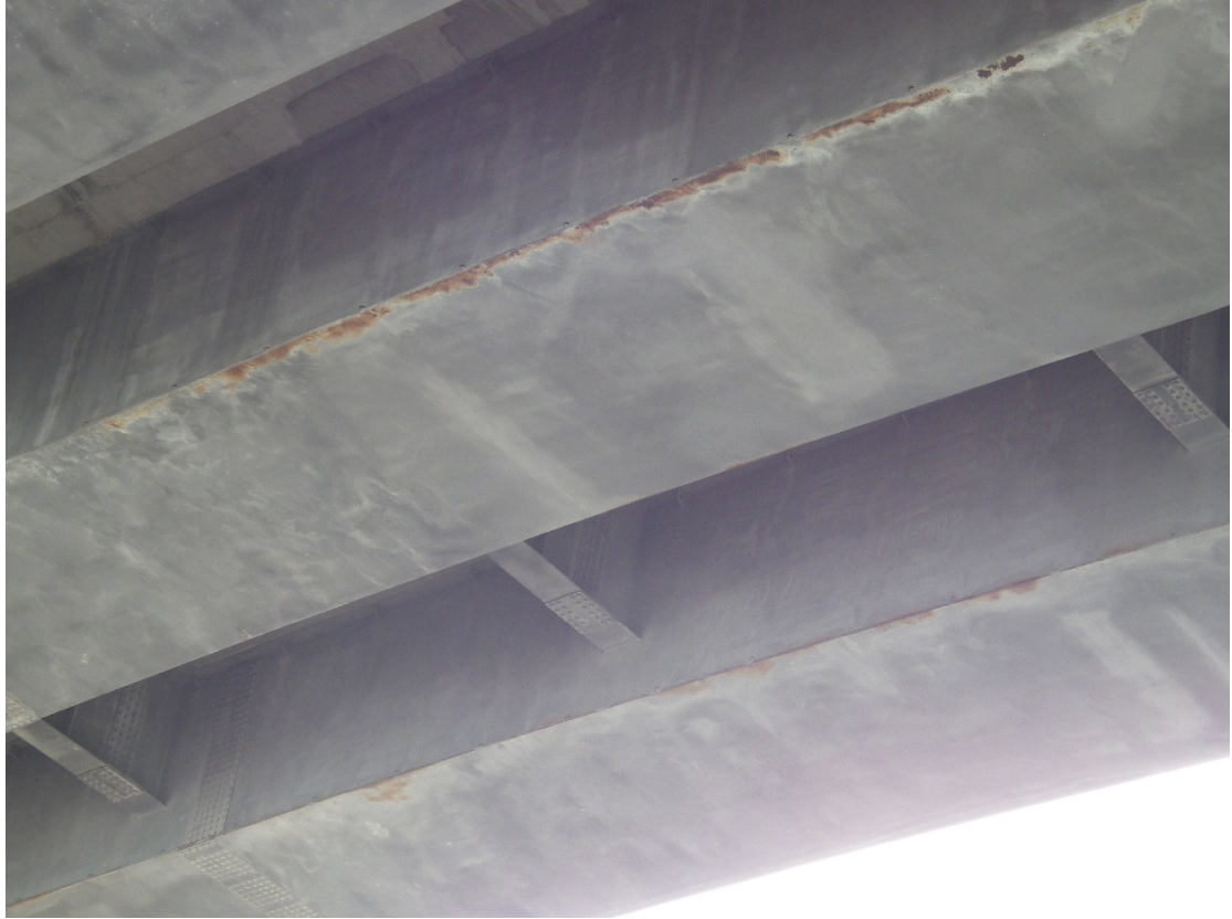
圖十四 台北橋三重端上方熔射箱梁(一標)生銹外觀(二)
