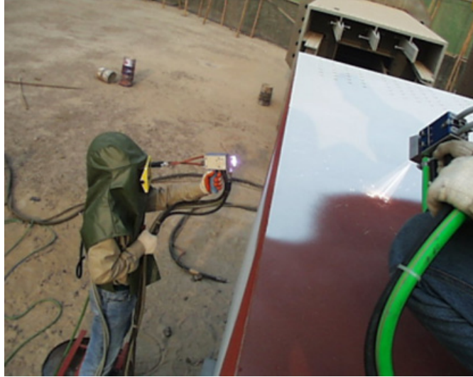
圖七 箱梁現場熔射情形
