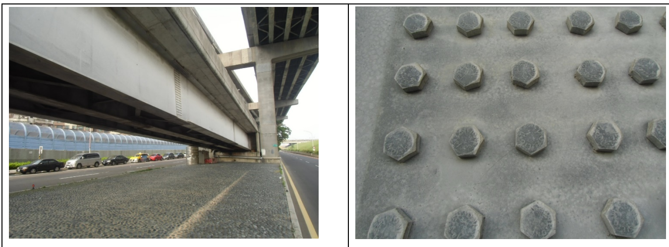
圖十二 三重市重安街匝道熱浸鍍鋅板梁(中興橋，二標)外觀
