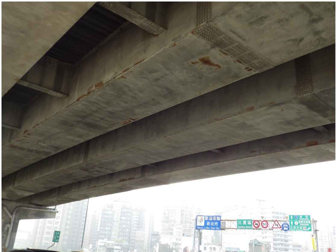
圖十五 忠孝橋三重端上方熔射箱梁(二標)生銹外觀
