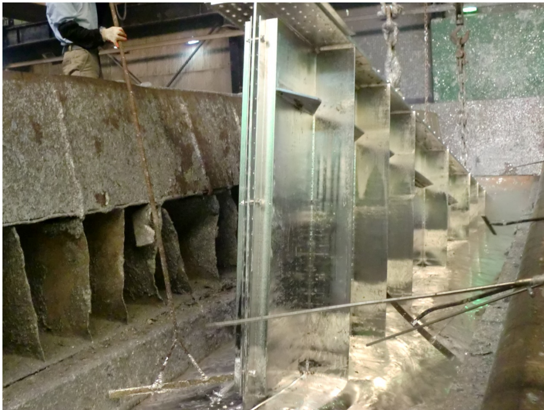
圖十 板梁熱浸鍍鋅情形
