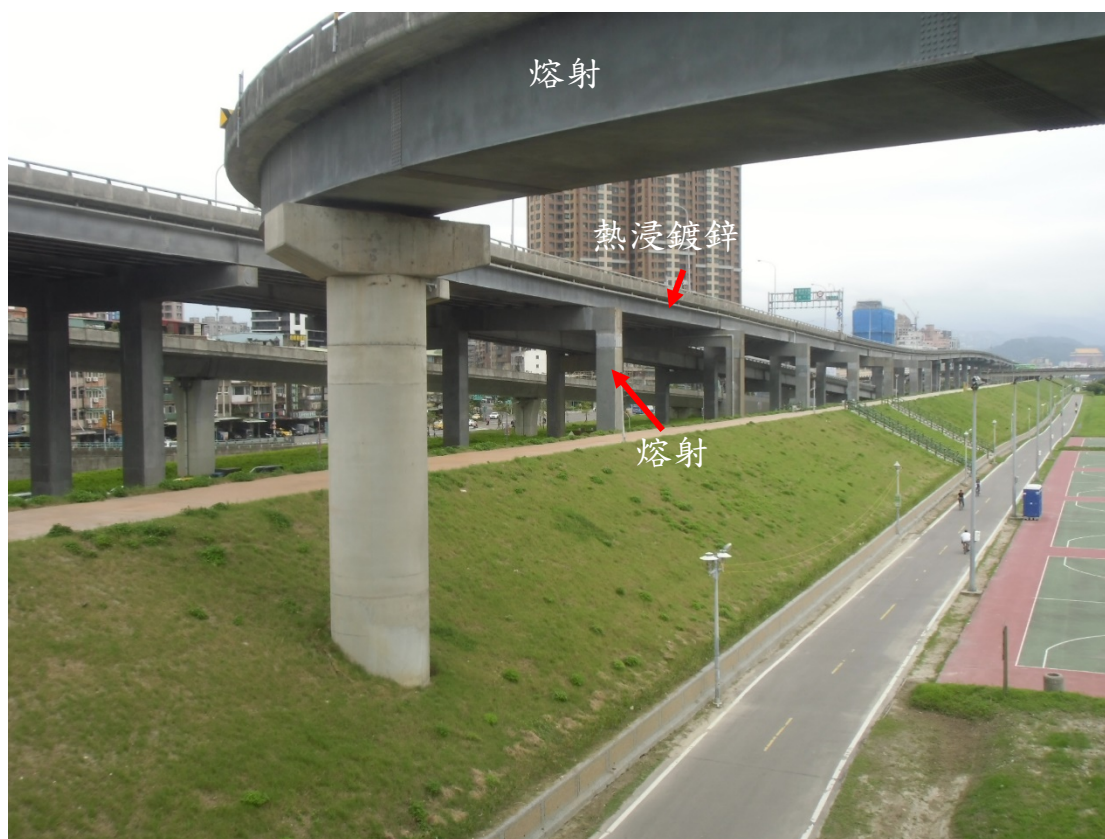
圖一 新北環快中興橋處(二標)，箱梁採熔射防蝕，I 型板梁採熱浸鍍鋅防蝕
