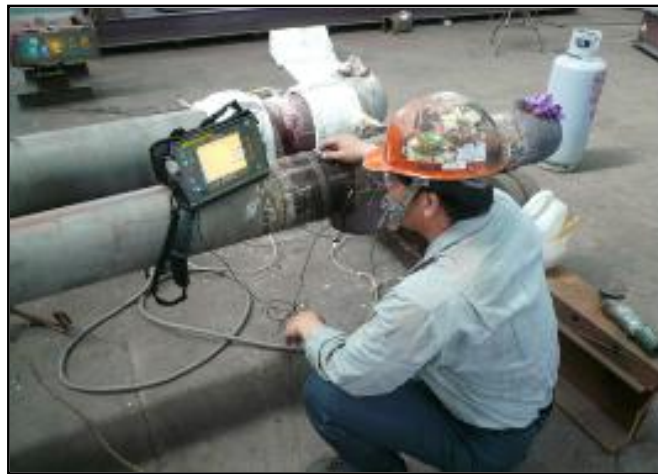
圖 5 管件銲道超音波檢測
