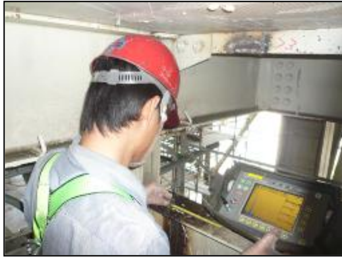
圖 4 現場鋼結構銲道超音波檢測
