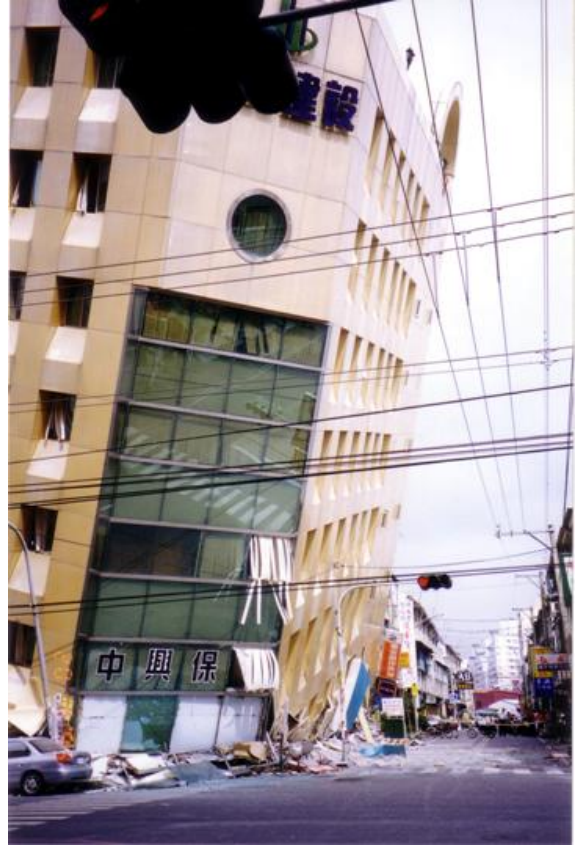
圖1 軟弱底層嚴重破壞或倒塌
