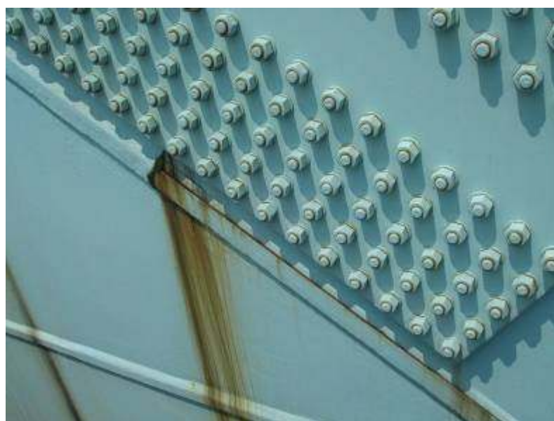
圖一 螺栓表面油漆保護有缺陷而容易生鏽
