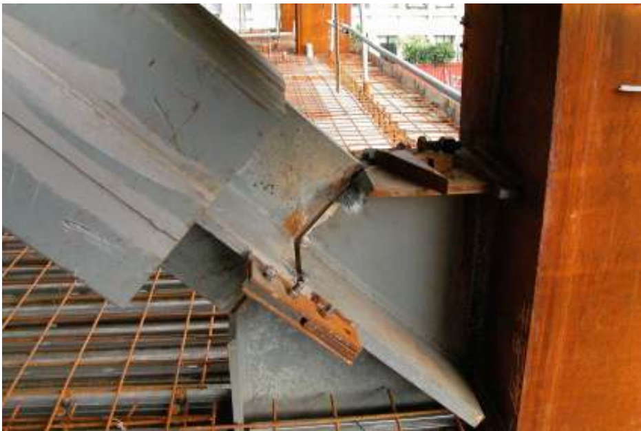
圖 2-9 鋼側撐 BRB 之假固定待銲接
