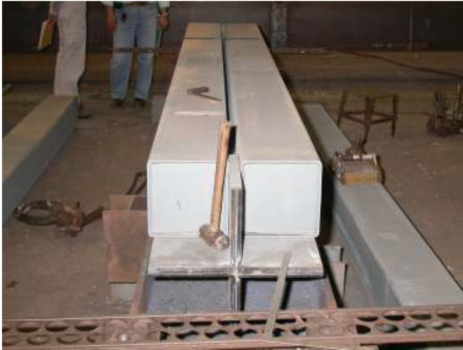
圖 2-8 鋼側撐元件之組立與密接度之檢查
