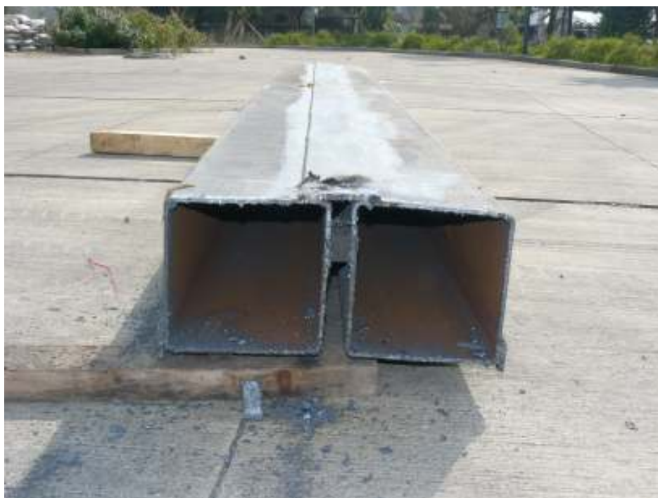
圖 3-16 試驗後 BRB 試體側撐元件之檢視情況
