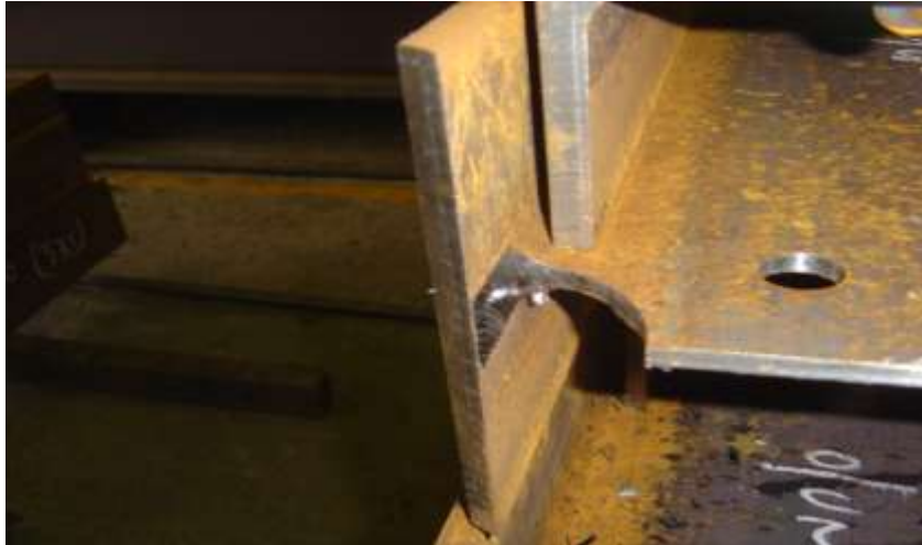
圖 4 梁端扇形孔
