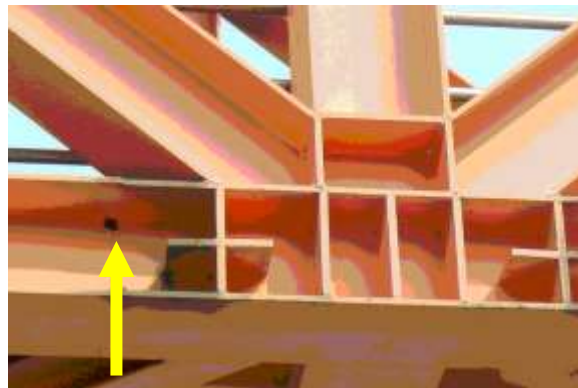
圖 15 小斷面桿件建議採單側開扇形孔
