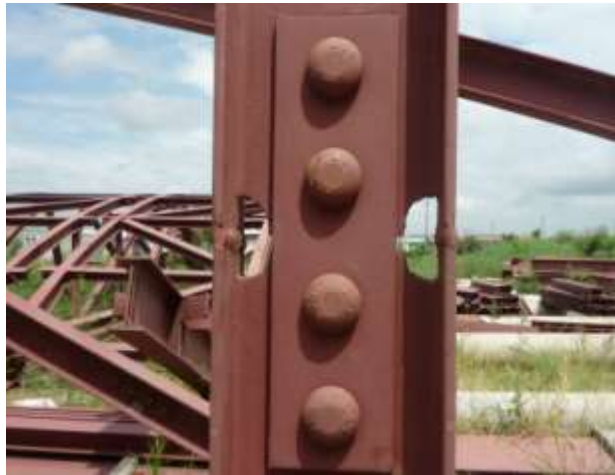
圖 14 小斷面桿件建議採單側開扇形孔或減小扇形孔尺寸
