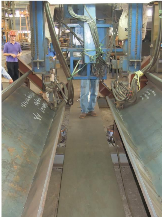
圖 3.1 潛弧銲機進行 BH 型鋼製作
