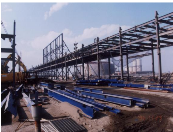
圖十 台塑六輕工程公共管架
