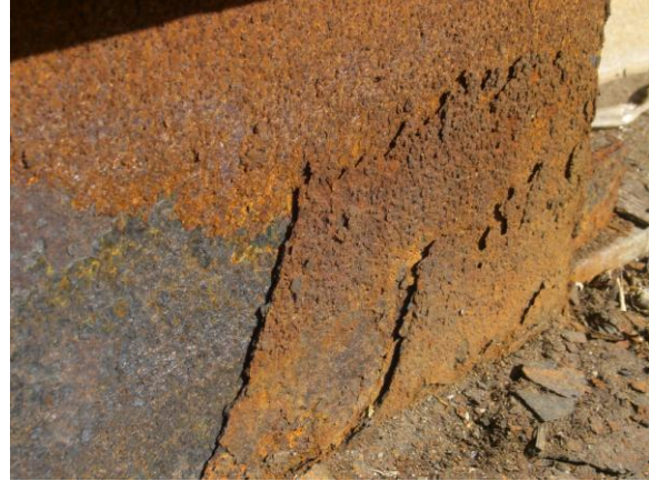
圖七 銹層間隙容易含水反覆生銹
