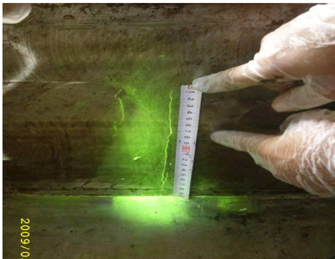
圖七 磁粒檢測(MT)之裂縫狀況
