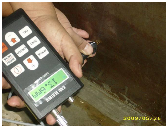
圖八 裂縫偵檢儀之現場檢測
