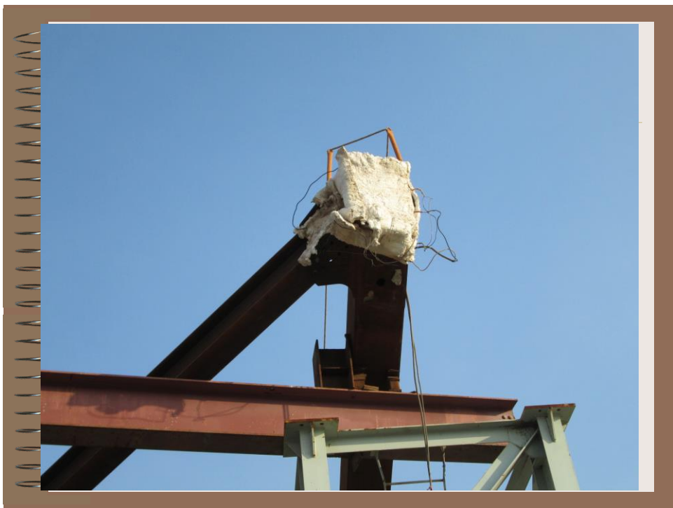
銲後熱應力消除照片 11
