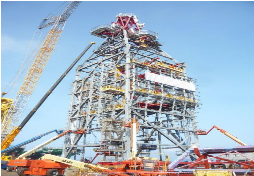
鑽油塔架外觀照片 1
