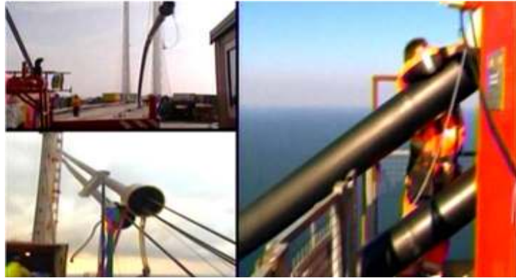
圖 19 索塔與橋樑組件間的纜索安裝
