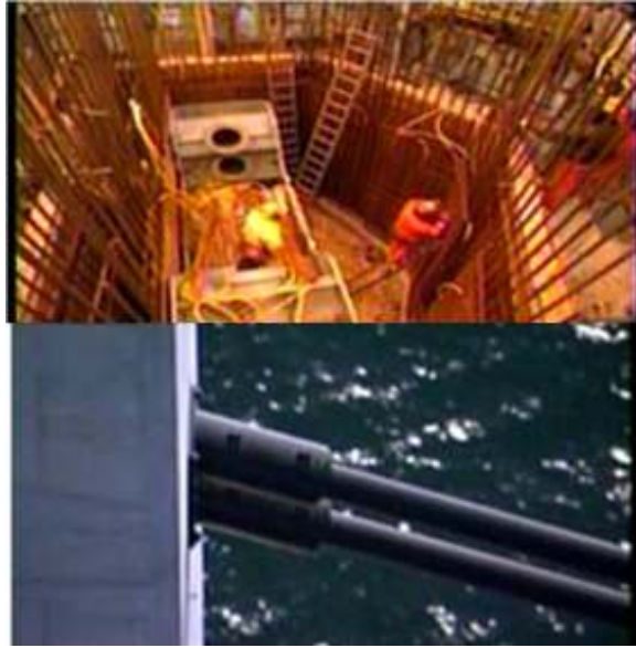
圖 15 安裝鋼箱以固定懸索
