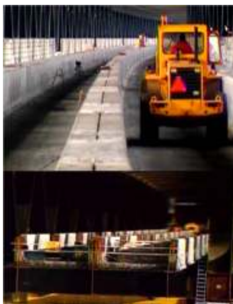
圖 17 鐵軌鋪在水泥槽內，防止火車出軌時落海
