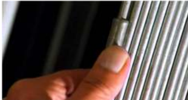
圖 9 構成吊橋的鋼索比拇指還細
