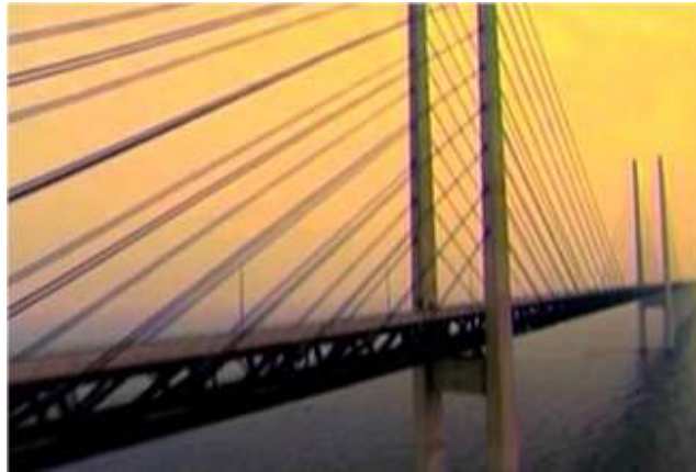
圖 12 兩根索塔只由行車到下的橫梁連接
