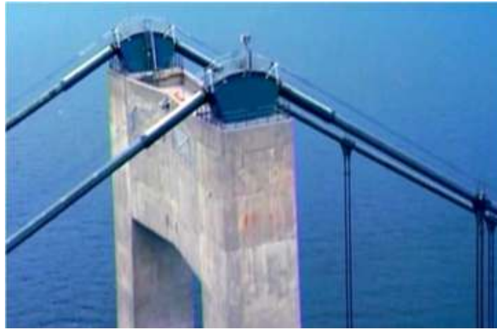
圖 8 索塔上支撐橋梁的兩條纜索
