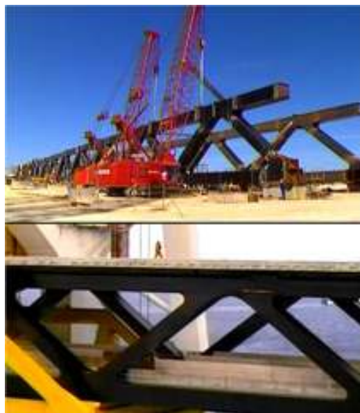
圖 16 雙層橋箱型鋼結構跨距的組裝及建造
