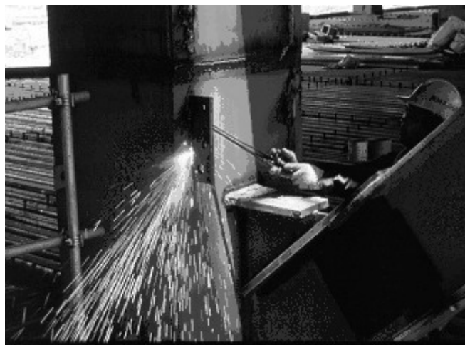
圖 9-1 鋼柱之吊耳切除 [1]
