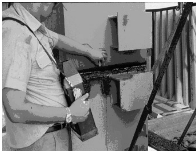
圖 9-11 工地全滲透電銲之超音波檢測 [1]
