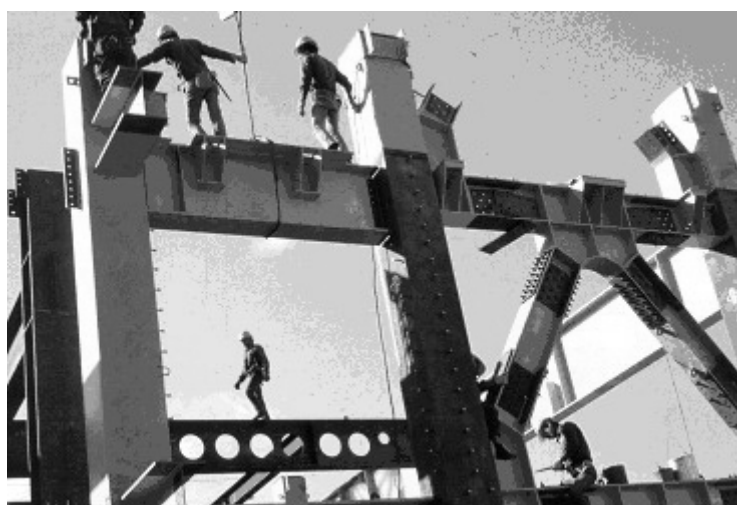
圖 11-3 鋼結構之高空作業十分危險 [1]
