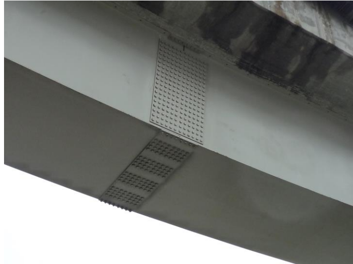
圖 2：箱型鋼梁腹板接合螺栓數量較翼板接合螺栓數量多之案例。
