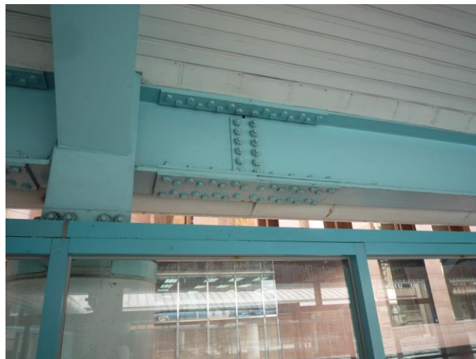
圖 10：消散腹板傳到翼板的彎矩之建議角度 30 度
