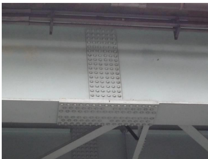
圖 6：H 型鋼梁腹板接合螺栓數量較翼板接合螺栓數量多之案例。
