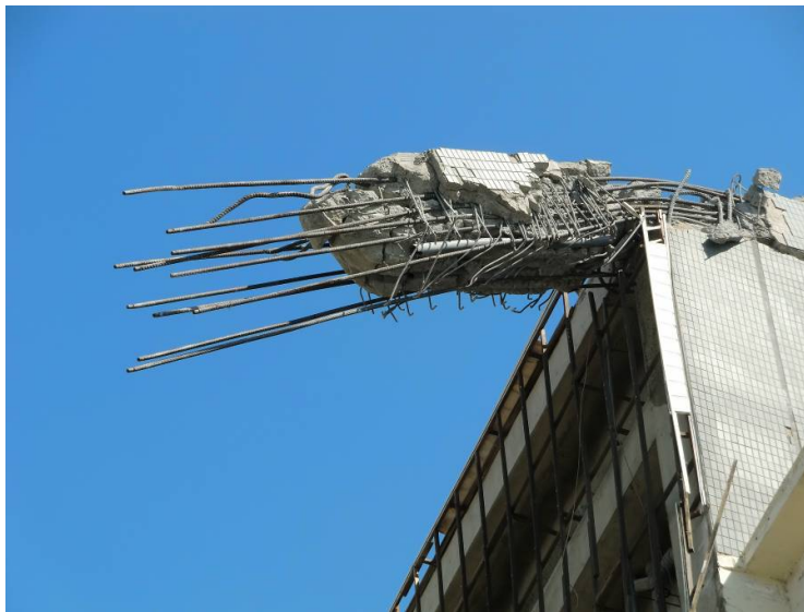
圖 3：梁端錨定長度不足，及梁柱接頭箍筋不足。
