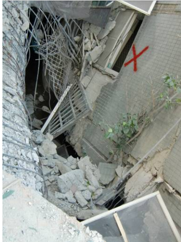
圖 5：一樓橫隔板北側有大範圍破損現象
