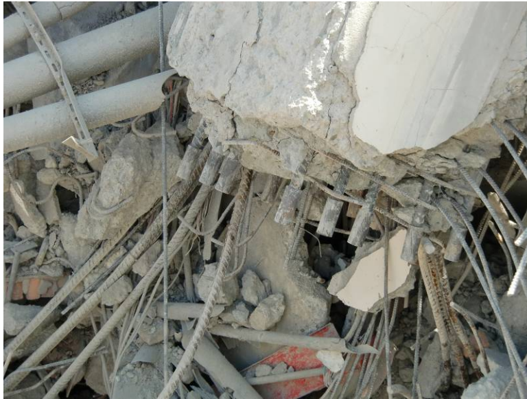
圖 4：箍筋閉合接頭 90 度彎鉤及鋼筋續接未錯開且有脫牙現象
