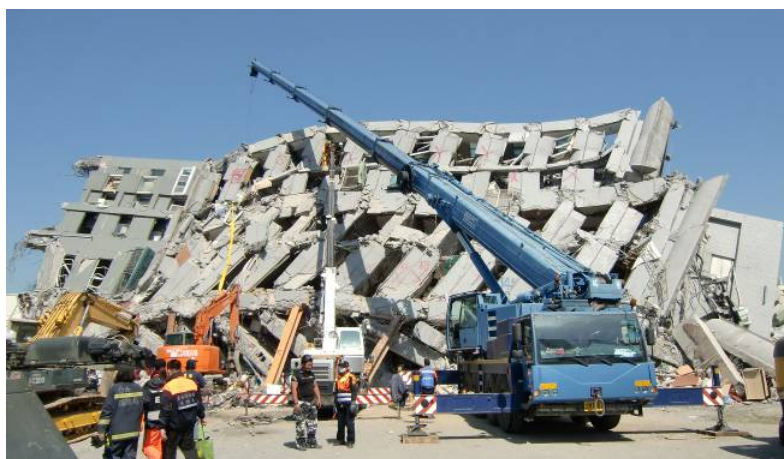
圖 1：維冠金龍大樓倒塌整棟橫躺在永大路二段上
