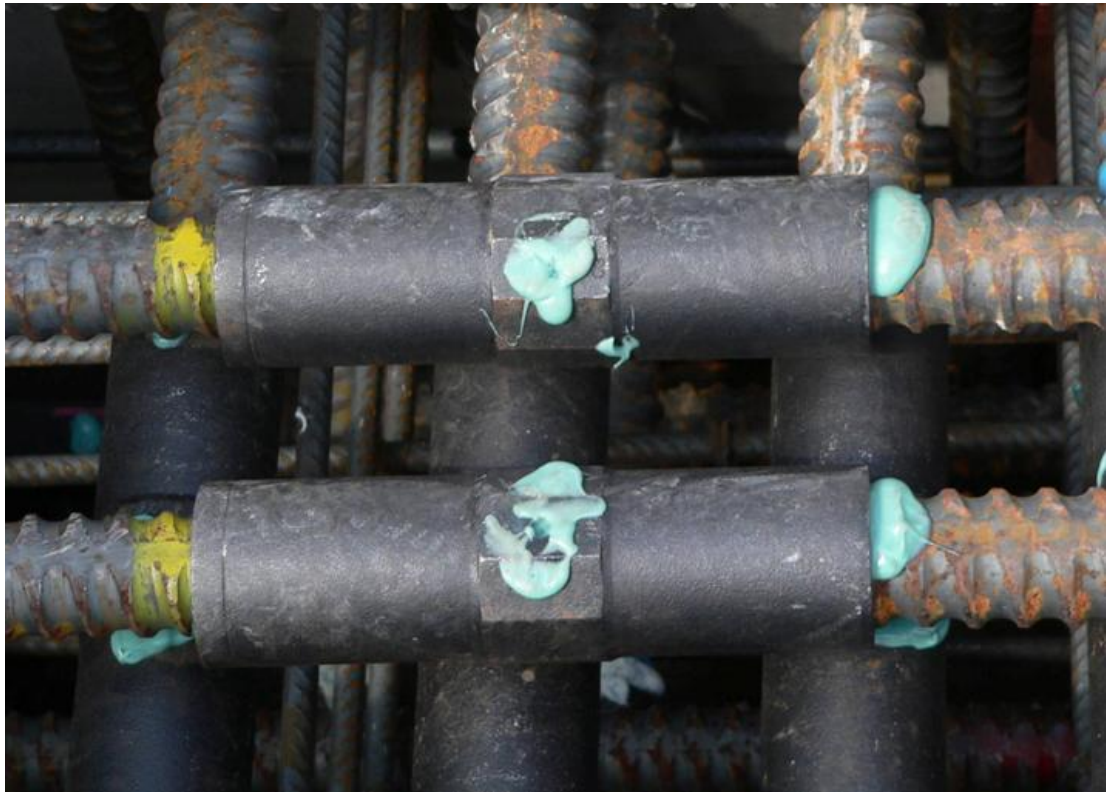
圖一 套筒續接圖 [潤泰、評輝營造曹昌盛]
