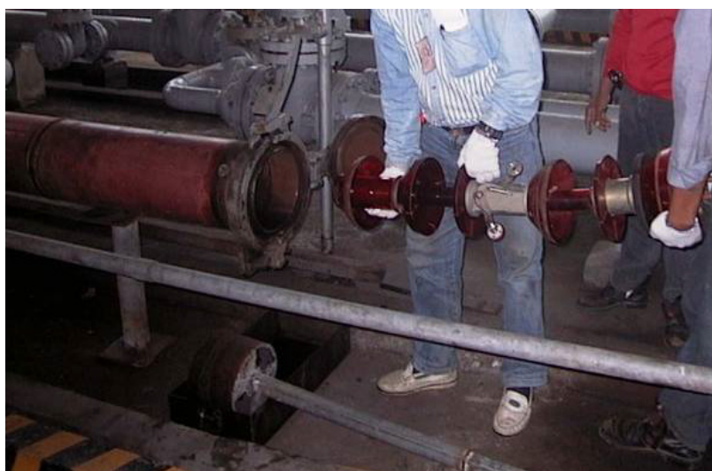
圖 9 地下管線之檢測
