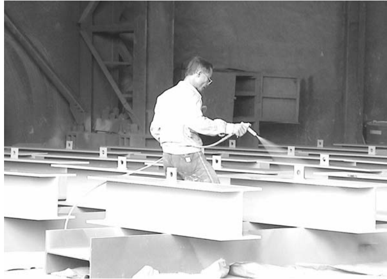
圖 8-3 鋼結構之噴塗油漆 【1】
