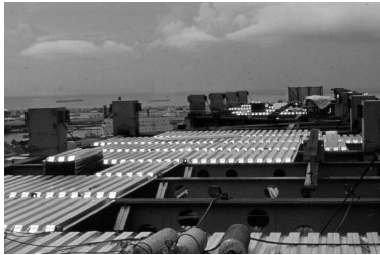
圖 5-12 端部壓扁式鋼承板
