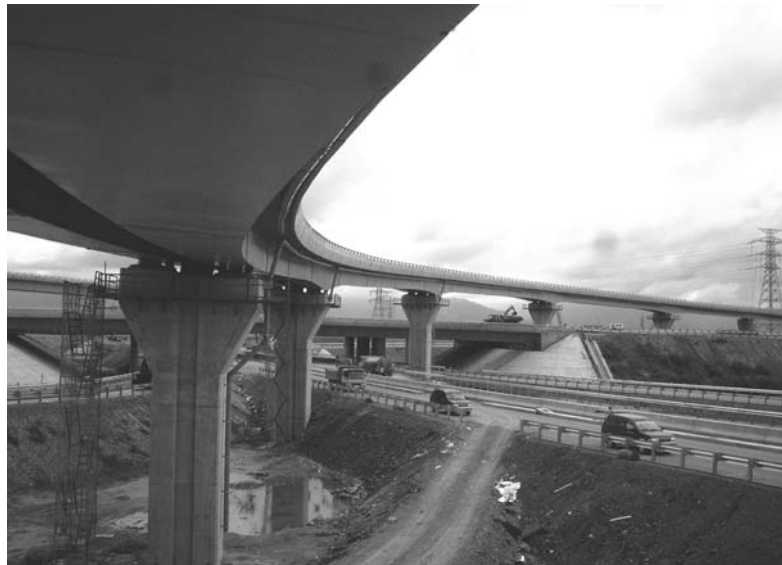
圖 8-4 鋼橋完成塗裝 【1】
