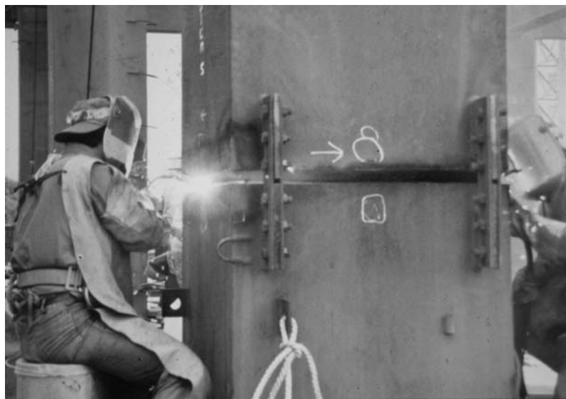
圖 5-11 工地電銲施作 [1]
