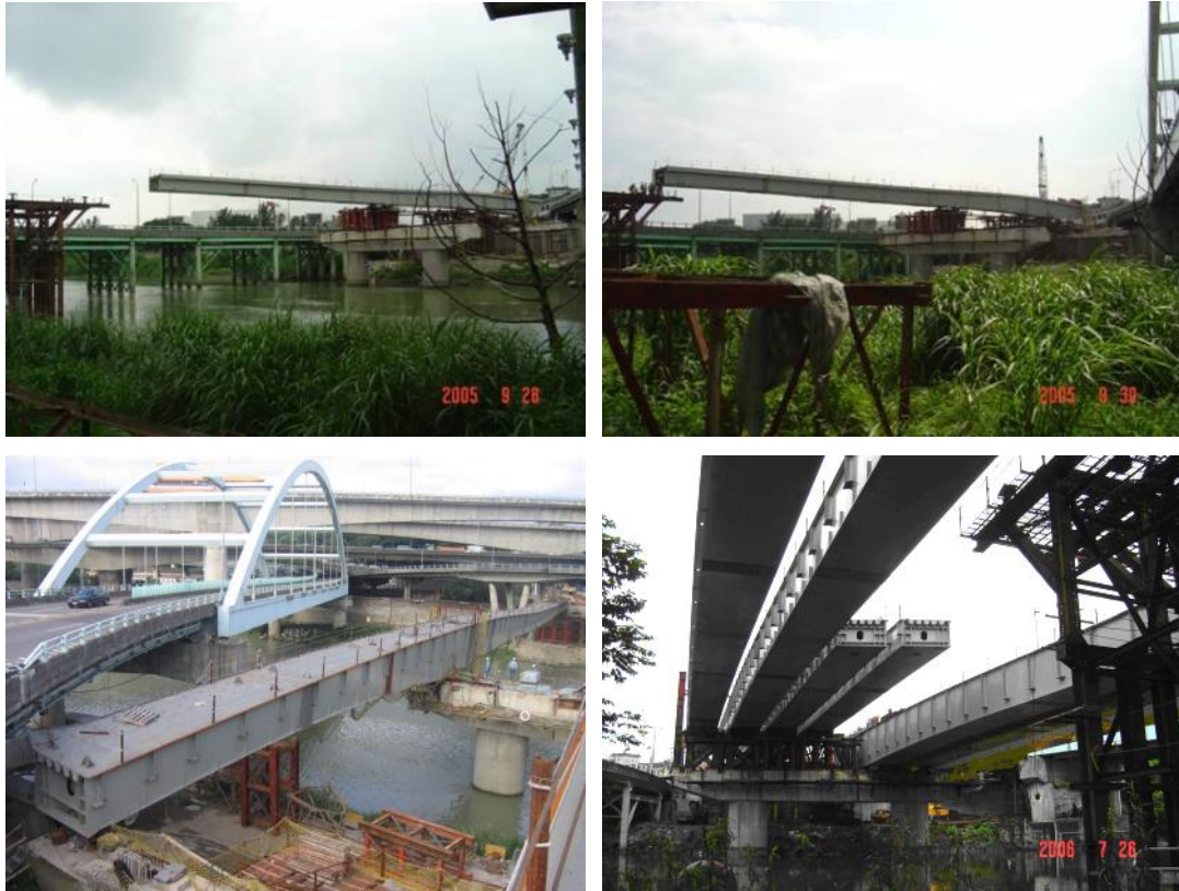
圖 18 臺北市中山橋改建工程鋼梁施工
