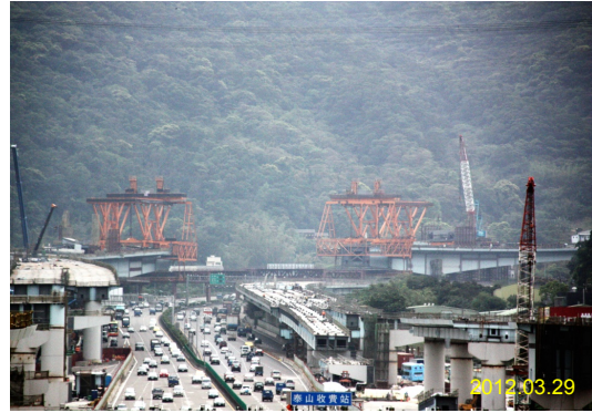
安裝工作車，組裝主梁
