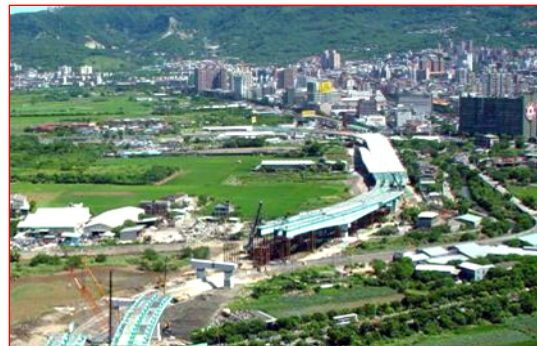
主梁吊裝(第二跨)
