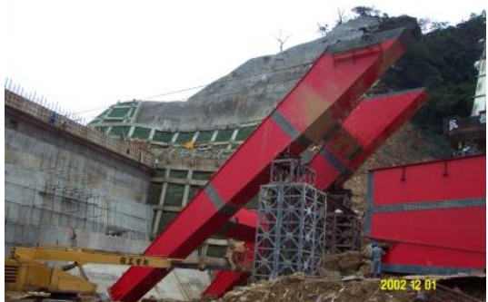
圖 15 彩虹橋鋼構施工
