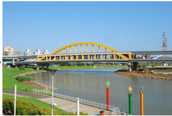
臺北市正氣橋改建工程
