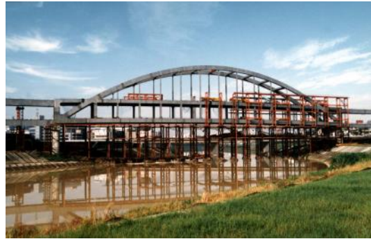
鋼拱橋吊裝完成後再拆除臨時支撐
