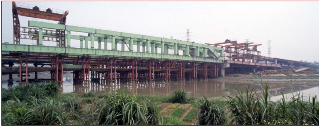
主梁採天車梁方式吊裝
