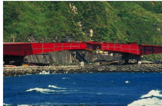
圖 6 十八王公橋懸臂施工
