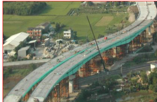
主梁吊裝完成
