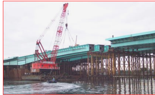
構件吊裝定位
