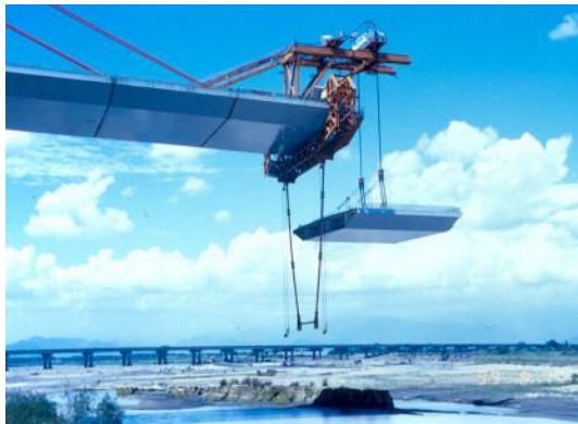
圖 10 高屏溪橋斜張橋主梁施工相片
