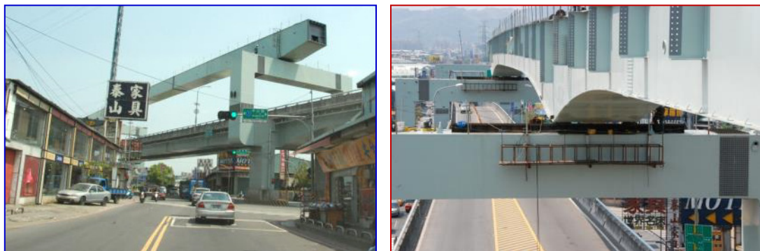
圖 19 機場捷運系統 CE01C 標工程鋼梁施工
