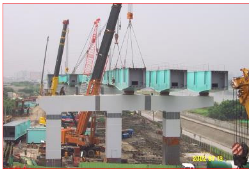
洲美快速道路工程
