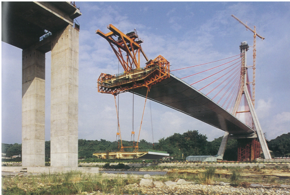
圖 9 高屏溪斜張橋主梁吊裝示意圖及現場吊裝
