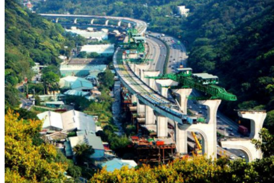
圖 21 五楊拓寬段 C903 標雙層高架橋施工
