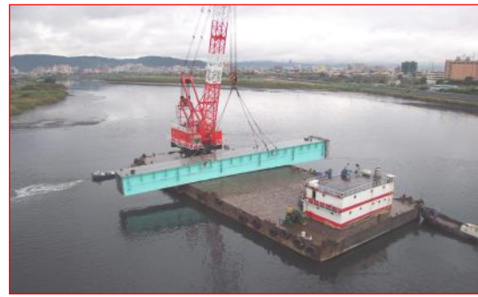
構件利用船吊作為運送工具
