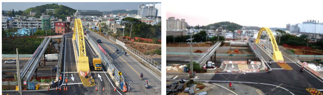
圖 20 五楊拓寬段校前路跨越橋施工
