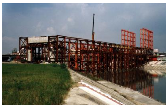
於鋼拱橋兩側架設臨時支撐架
