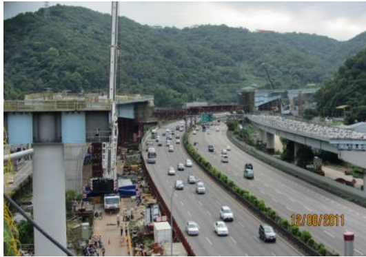
側跨場撐主梁吊裝
