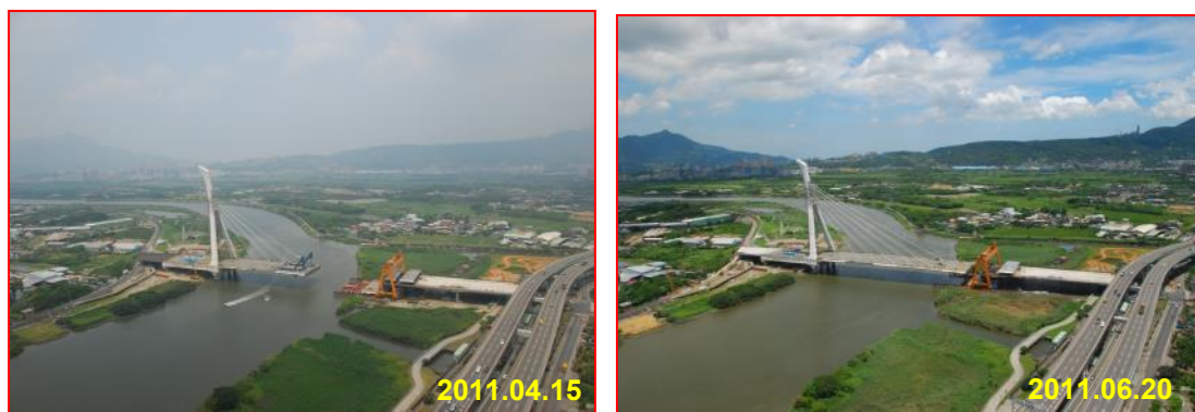
圖 14 社子大橋主梁吊裝施工
