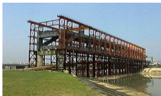
構件可利用中央部位的施工構台運送
