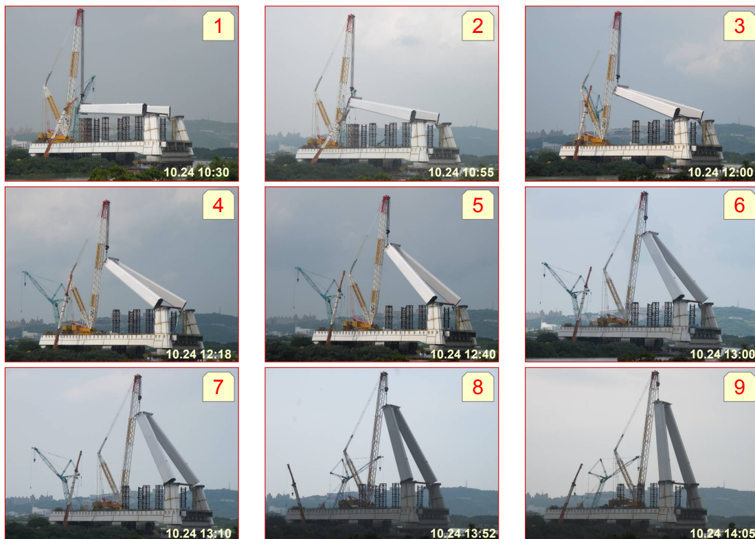
圖 26 社子大橋橋塔旋轉施工
