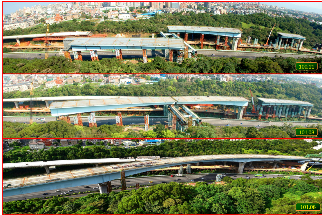
圖 24 五楊拓寬段主梁旋轉工法
