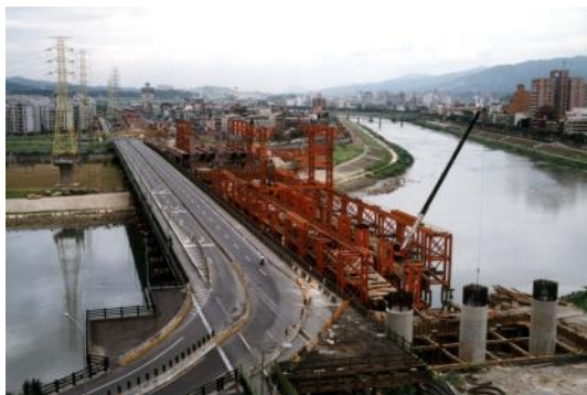
臨時支撐架及施工構台
