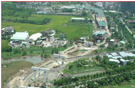
主梁吊裝(第一跨)
