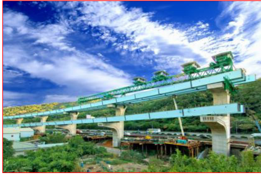
圖 21 五楊拓寬段 C903 標雙層高架橋施工
