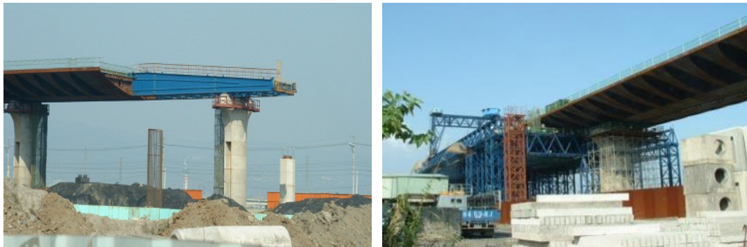
圖 17 台 64 線八里新店線 805 標工程鋼梁施工
