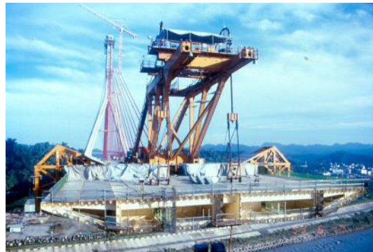
圖 10 高屏溪橋斜張橋主梁施工相片
