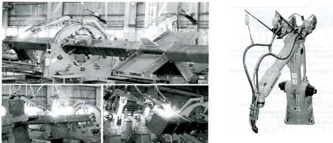
圖 4 日本機械人自動鐸接於鋼結構之應用實況 資料來源: Cloos Co., Message
