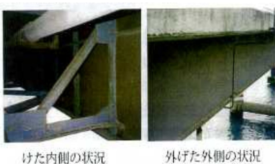
圖 7b 日本應用耐候鋼材料於鋼構橋樑，無塗裝使用 35 年
