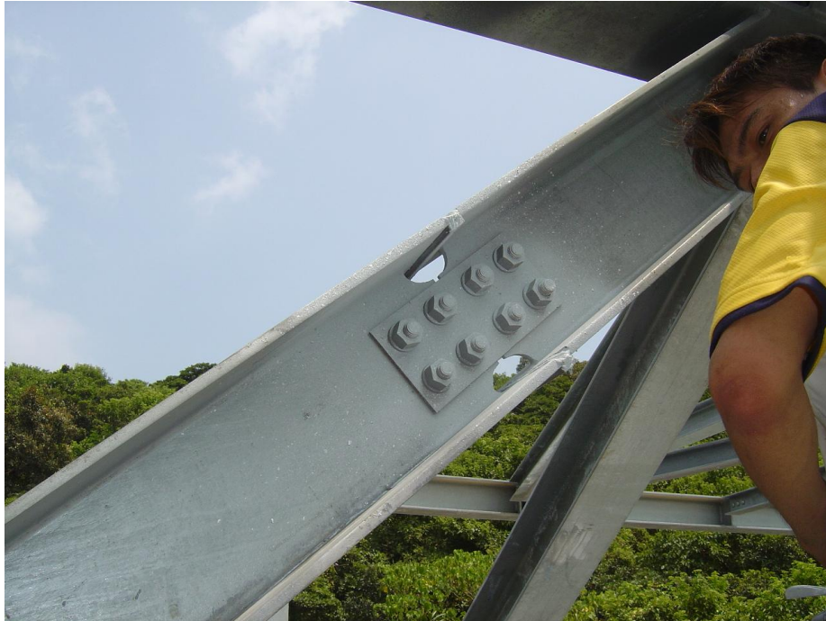
圖 6 鋅熔射修補後
