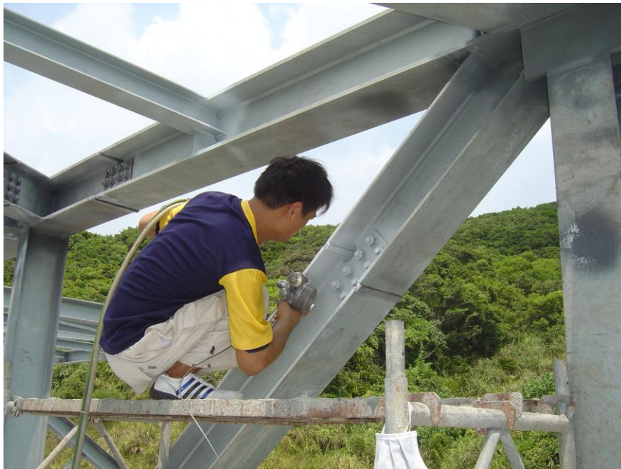
圖 5 鋅熔射修補中
