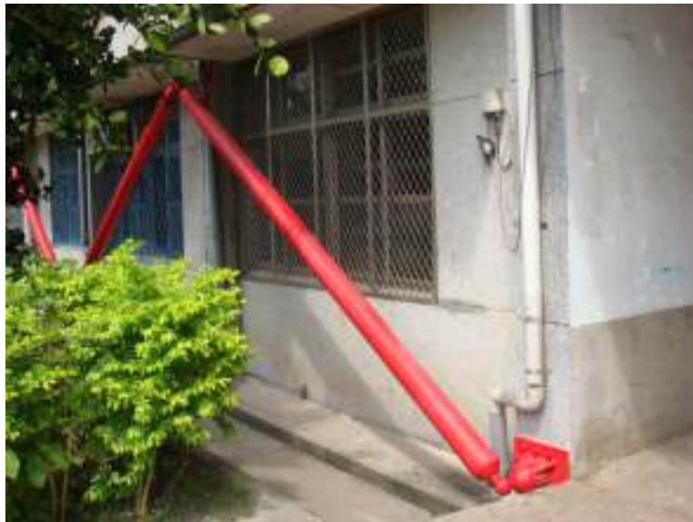
圖十一 無鋼框架之斜撐造成錨定點力量集中之現象。
