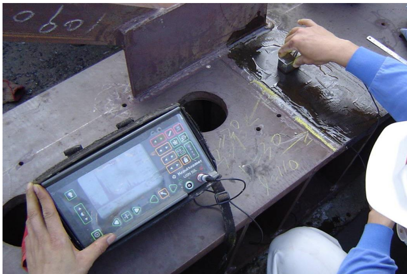
圖 8 鋼橋銲道超音波檢測
