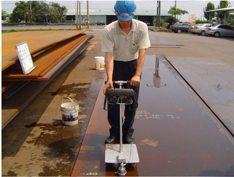
圖 7 鋼板夾層超音波檢測
