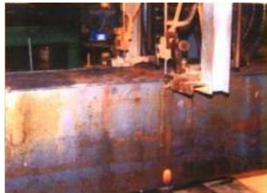
現場銲接操作
