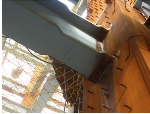
圖 1：減弱式梁柱接頭示意圖 [楊慶森]
