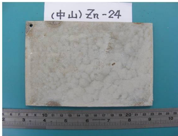
圖9. 熱浸鍍鋅鋼在中山大學曝露15.27年後之外觀
