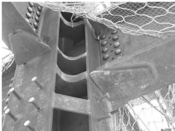
圖 7 梯形板補強實例
