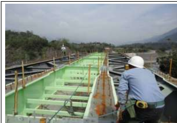
引道橋鋼箱樑拱度測量
