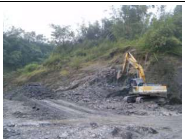
桁架橋吊裝區域半挖半填
