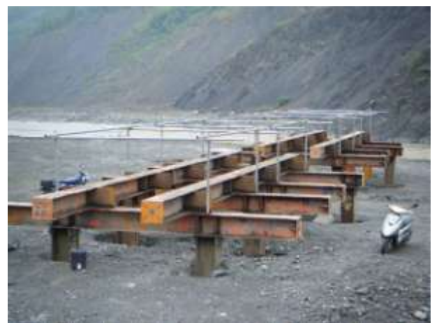
鋼橋臨時支撐鋼樁基礎完成
