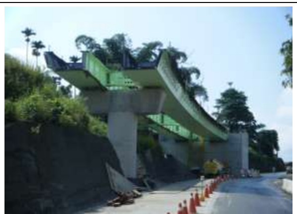
引道橋鋼箱樑完成
