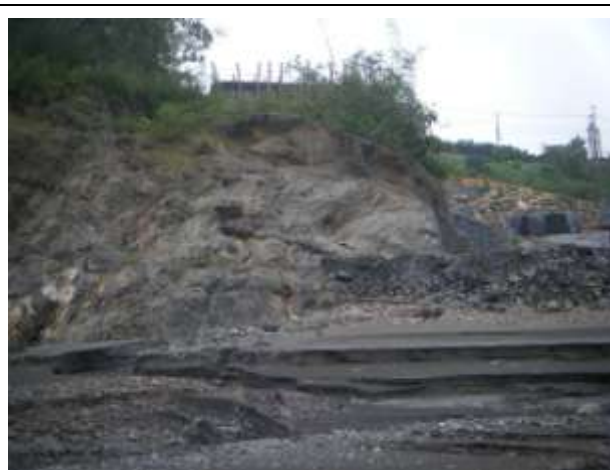
桁架橋吊裝區域（風化岩坡）
