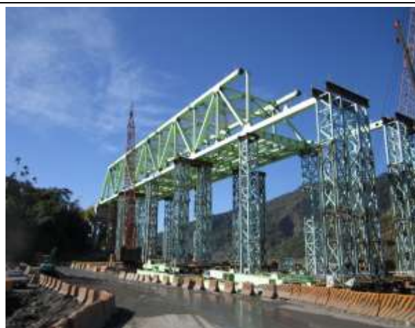
南側桁架橋吊裝
