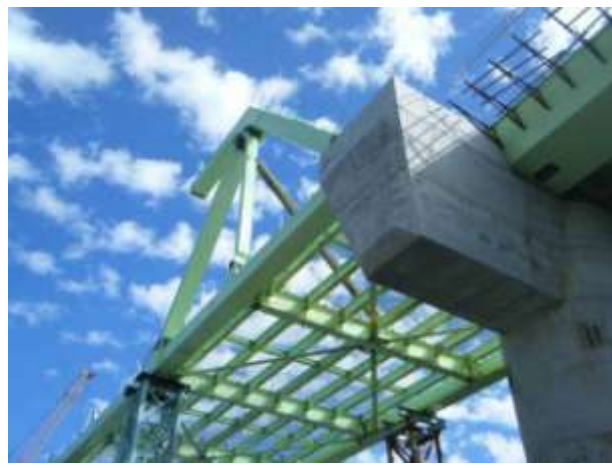
上弦縱樑吊裝完成
