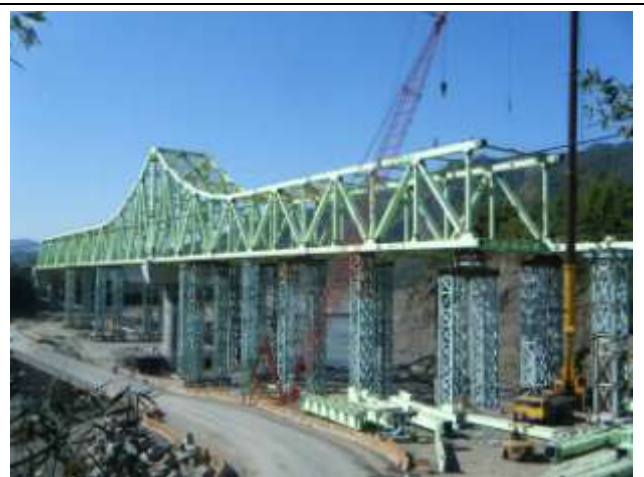
北側桁架橋吊裝
