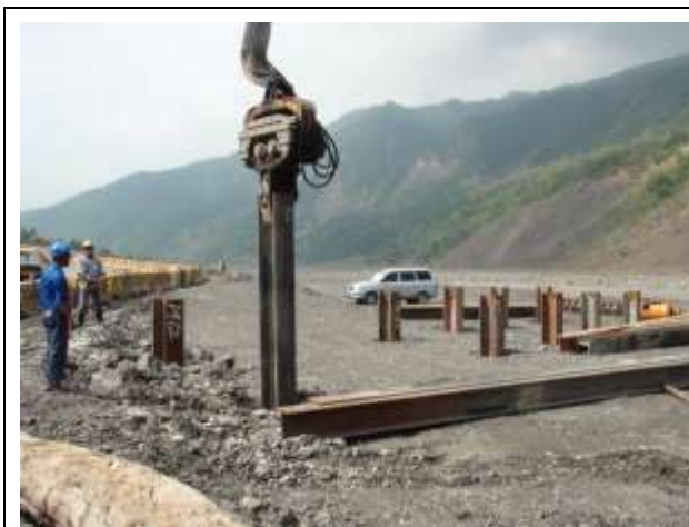
鋼橋臨時支撐鋼樁施工
