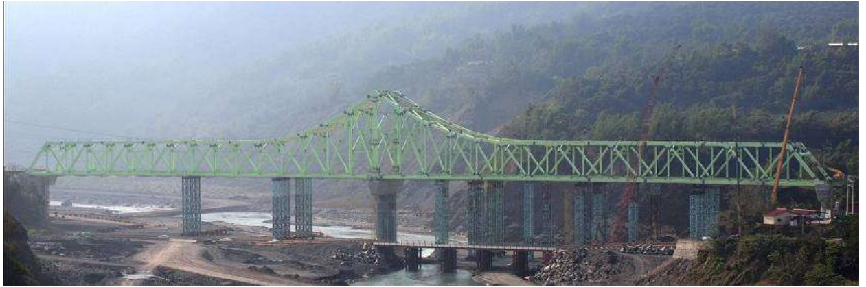
鋼橋吊裝完成全景
