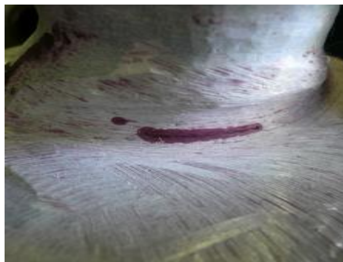
圖 3 銲道熔合不良之缺陷 (PT 檢測)
