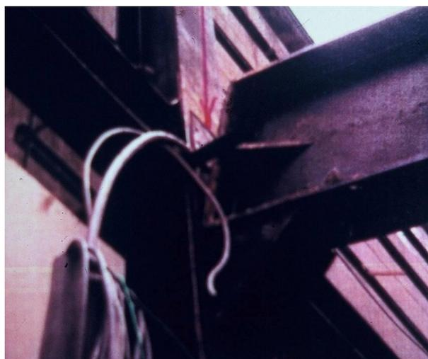
圖10：誤用高強度螺栓與銲接共同承受梁-柱接頭彎矩而造成倒塌之案例
