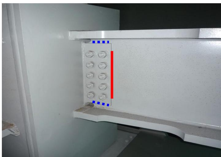
圖3：翼板銲接腹板栓接之接頭，腹板螺栓不得與腹板銲接共用[1]。
