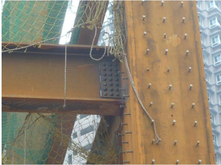
圖2：梁腹板接合螺栓數量太多，以銲接補強案例。
