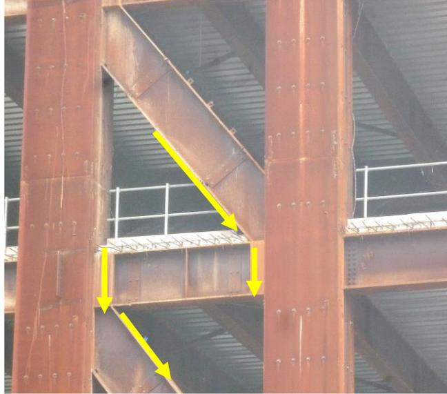
圖7：斜撐之垂直分力與梁之剪力，當梁有封板時須全鐸道承受。
