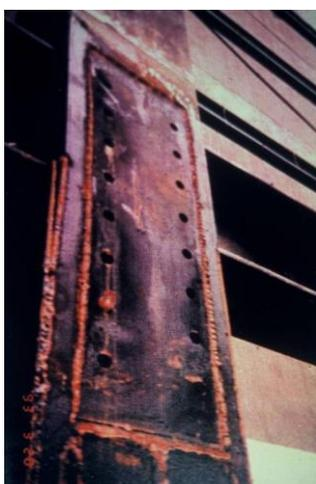
圖11：誤用高強度螺栓與銲接共同承受梁-柱接頭彎矩而造成倒塌之案例
